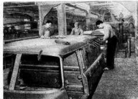
Bild 14. Die Dachschale wird auf die Karosserie aufgepaßt
